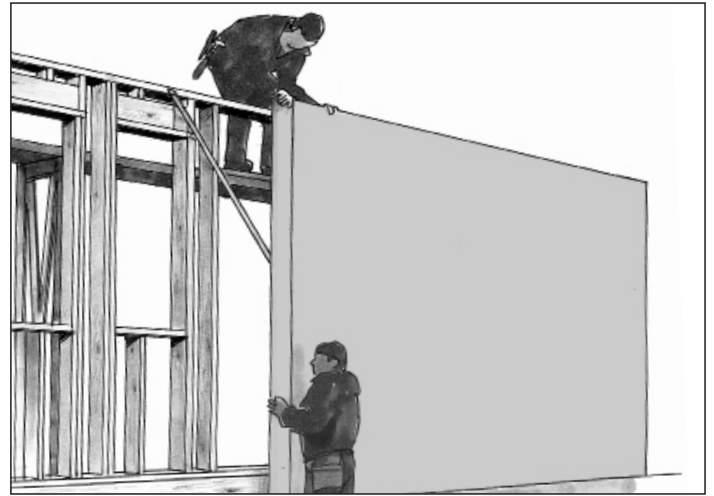
Elementtiseinän asennus
